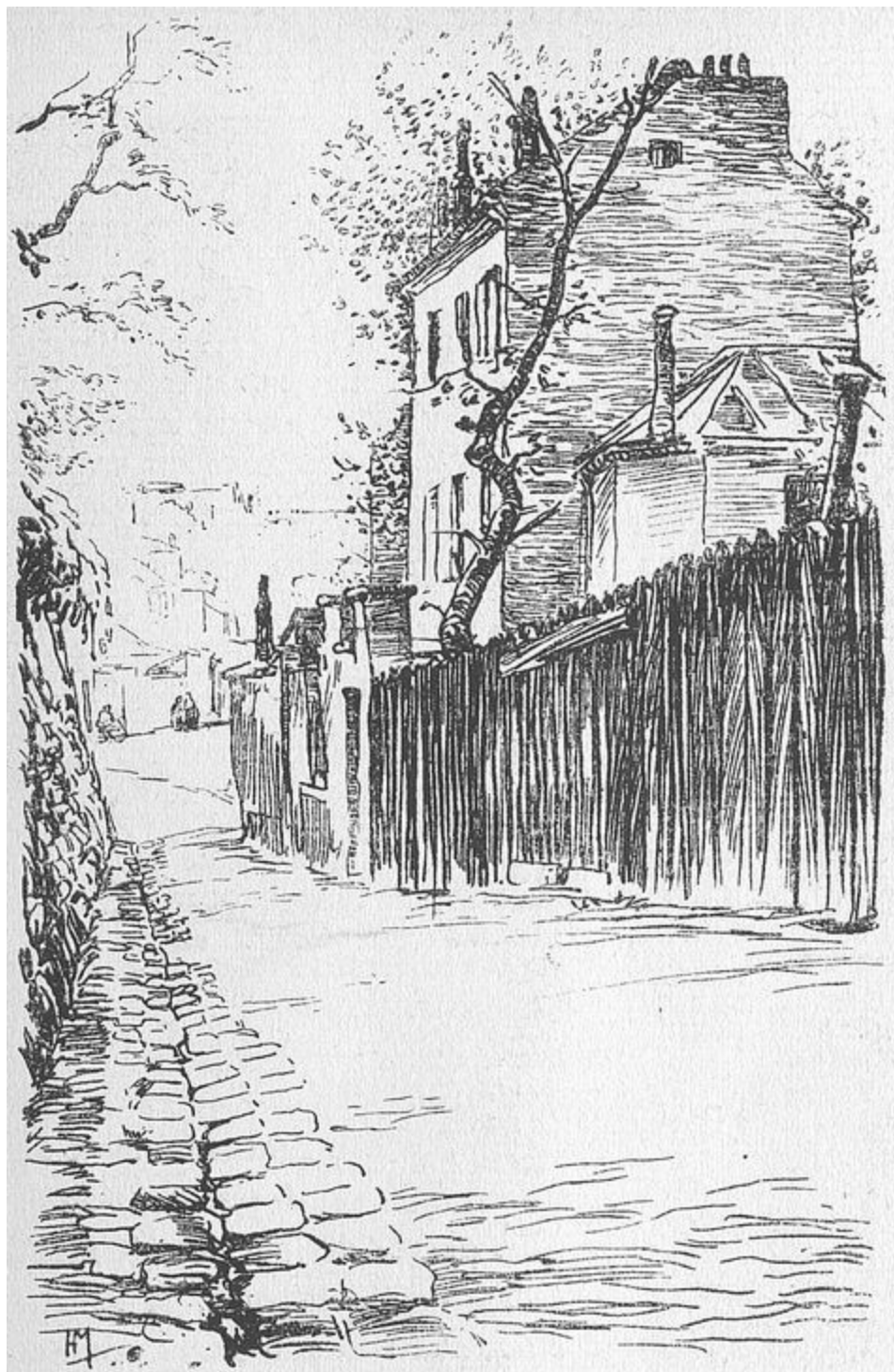
TERRAIN ENTRE LA RUE SAINT-VINCENT ET LA RUE LAMARCK
