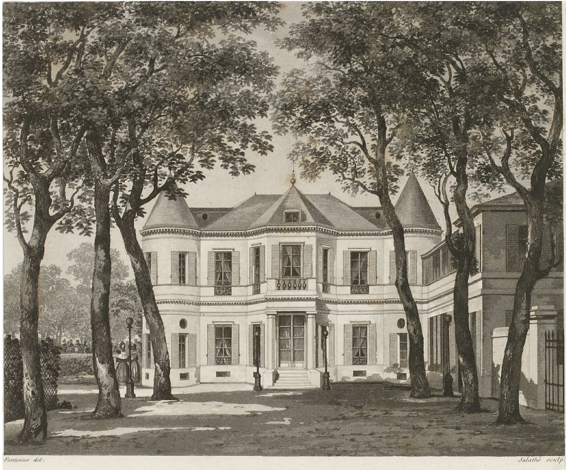
Vue du Pavillon de Wüntemberg du côté de l'entrée
