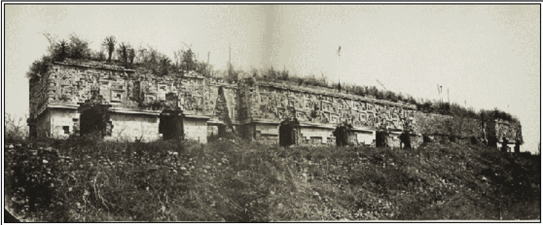
Palais Du Gouverneur, à Uxmal; façade principale.
