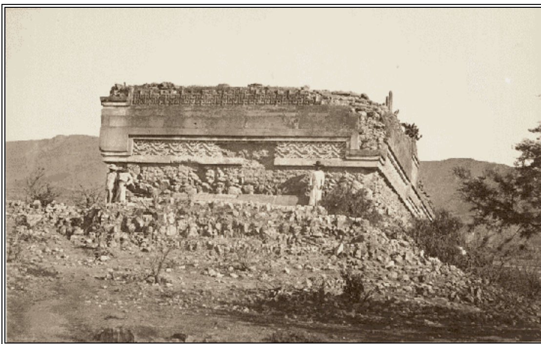
Quatrieme Palais, à Mitla; cote sud.
