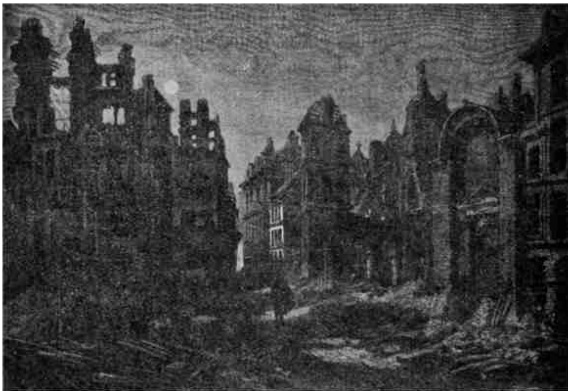
DÉMOLITIONS SUR L'ACTUEL EMPLACEMENT DU BOULEVARD SAINT-GERMAIN.
