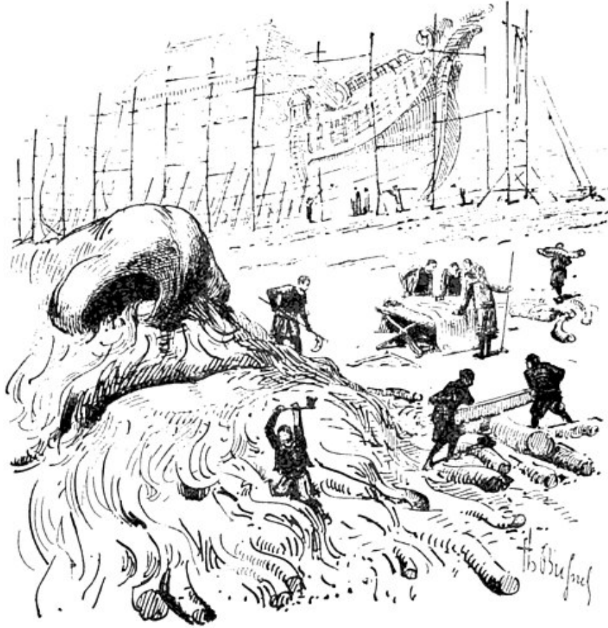
La construction de l'arche.
