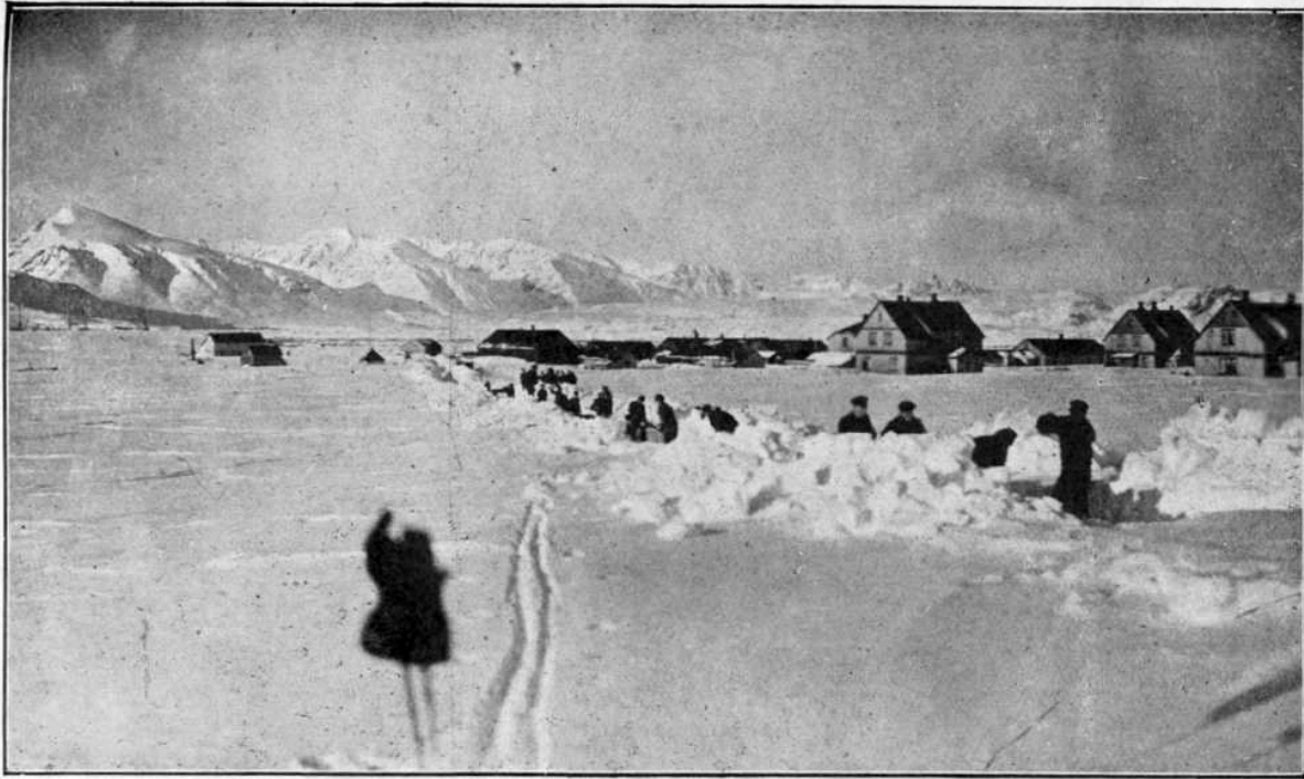
Le déblayage de la voie ferrée à Ny-Aalesund. Spitsberg.
