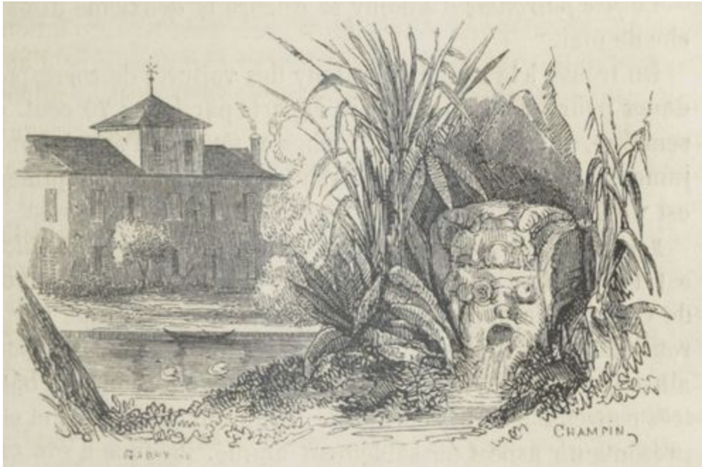
Prise d'eau à Rungis.
