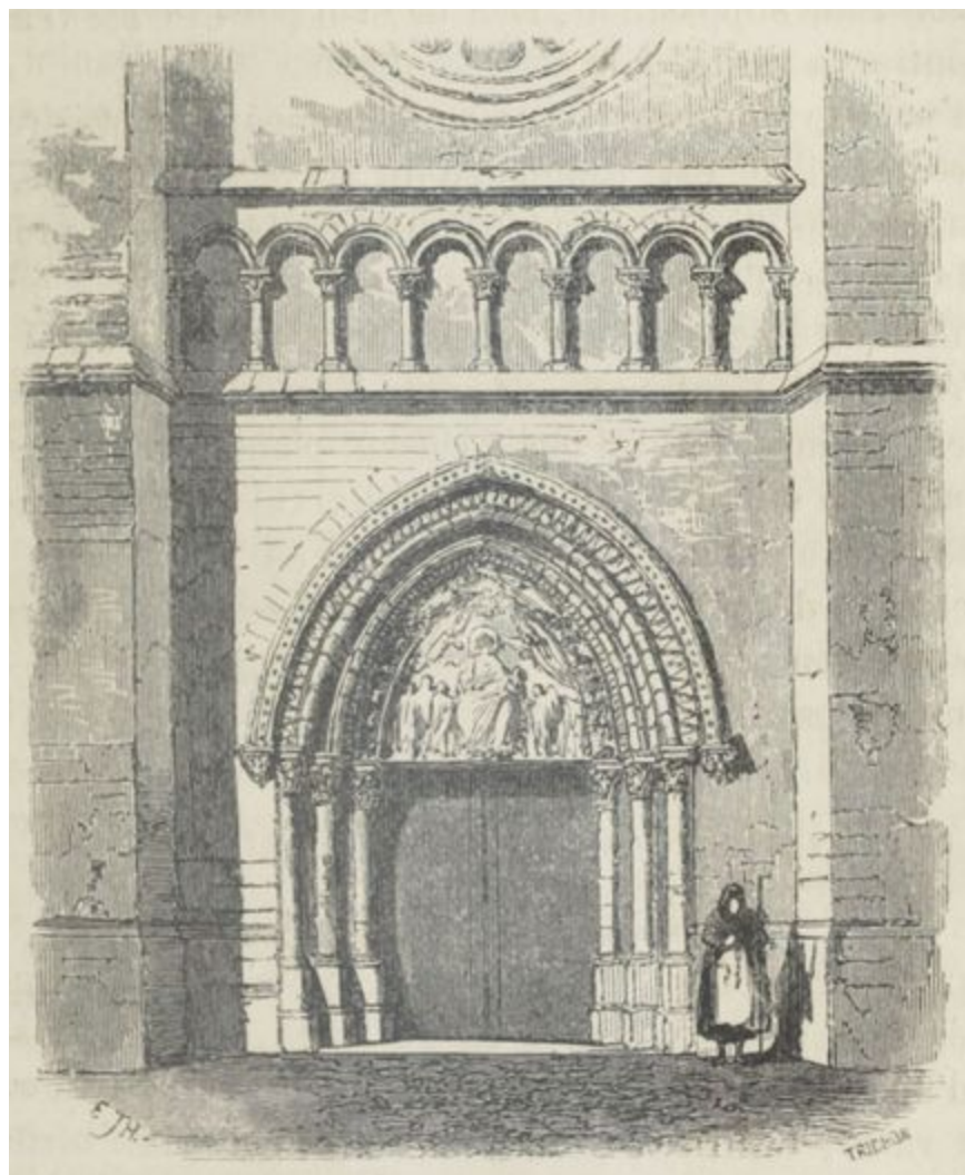
Portail de l'église de Bagneux.
