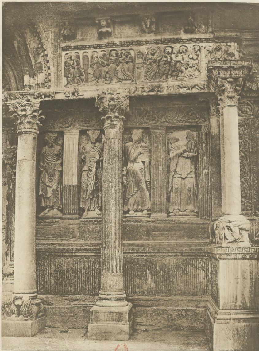
FAÇADE DE SAINT-GILLES Côté gauche
