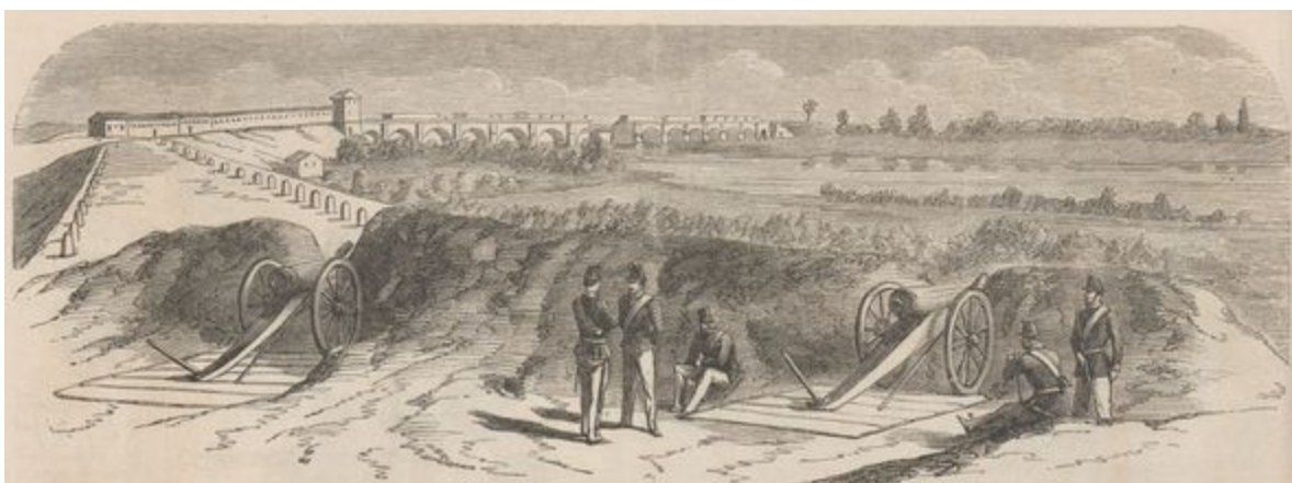
PONT DU CHEMIN DE FER DE VERCEIL, COUPÉ PAR LES AUTRICHIENS.
