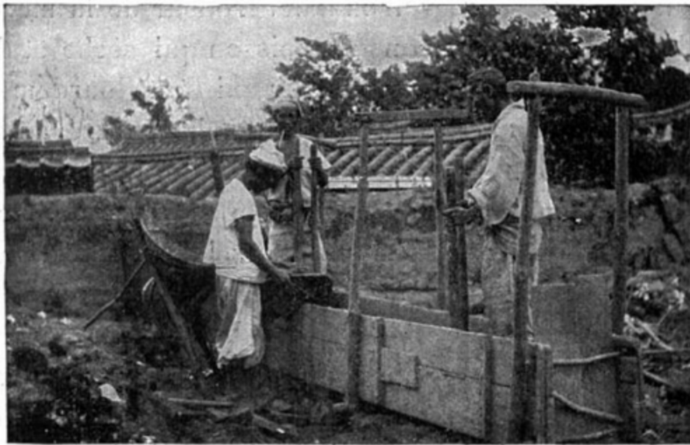
OUVRIERS INDIGÈNES TRAVAILLANT À LA FABRICATION DE LA BRIQUE
