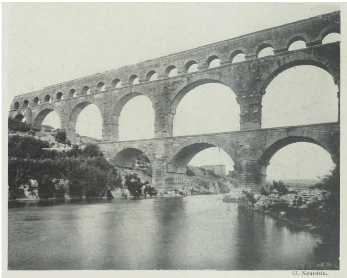
Pont du Gard (19 avant J.-C.).
