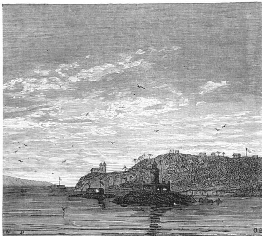
Fig. 42. — Phare à l'entrée d'une baie.
