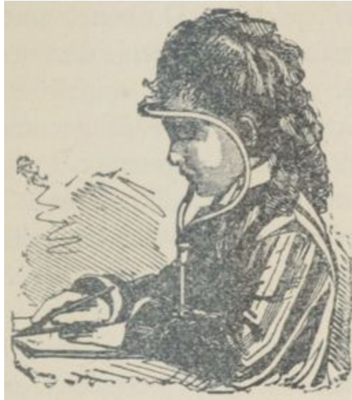
Fig. 37. — Appareil de Kallmann pour fixer et maintenir la tête à une bonne distance de la table de travail.
