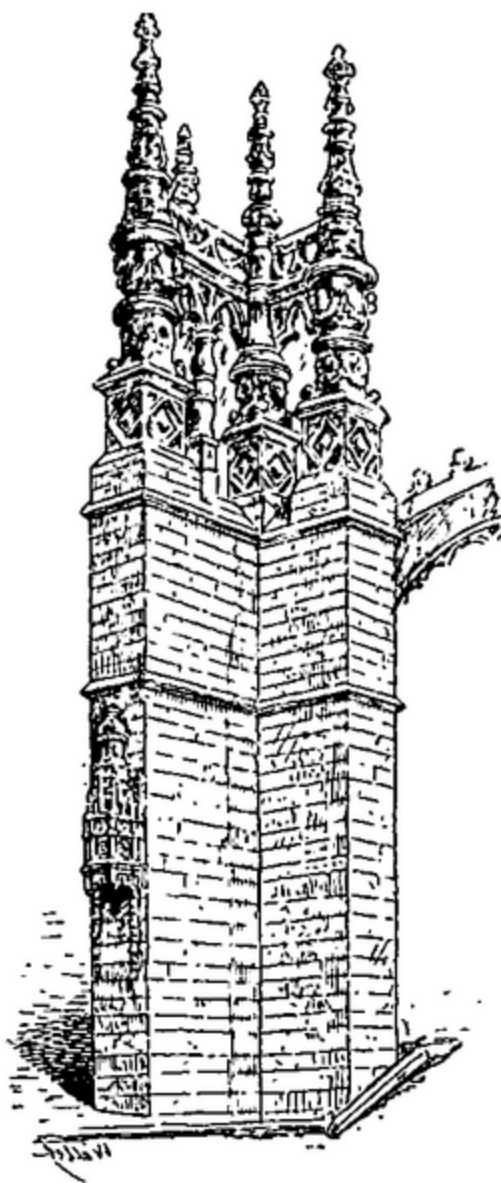
Fig. 80. — Contreforts de l'église Saint-Salomon, à Pithiviers.
