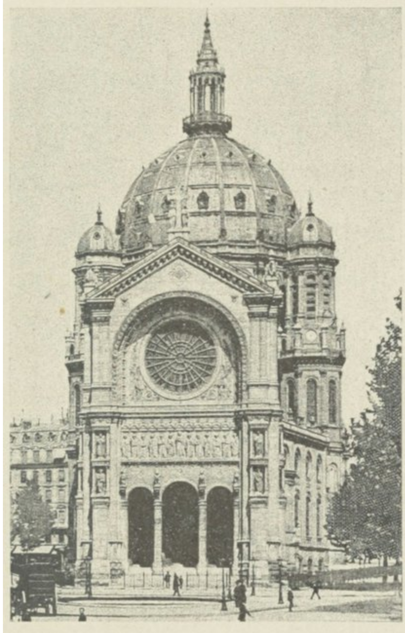
FIG. 15. – Église Saint-Augustin, à Paris. Vue extérieure. V. Baltard, architecte.
