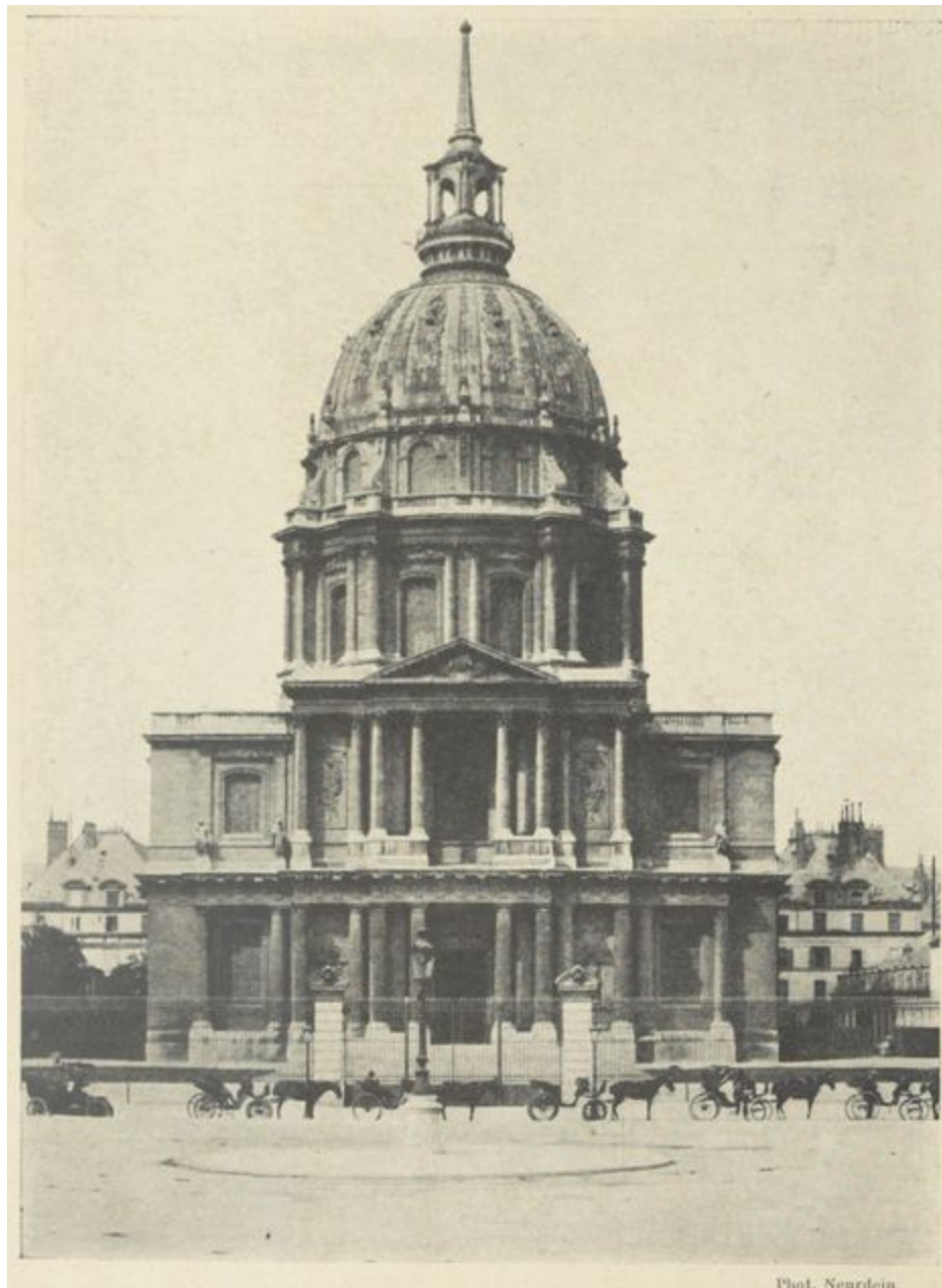
Fig, 70. — Dôme des Invalides. (Vue extérieure).
