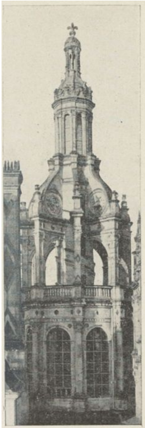
Fig. 61. — Château de Chambord (lanterne du grand escalier).
