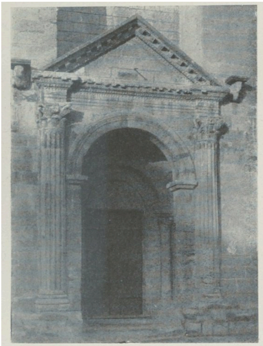
Fig. 10. – SAINT-RESTITUT (DROME). PORTE LATÉRALE DE L'ÉGLISE.
