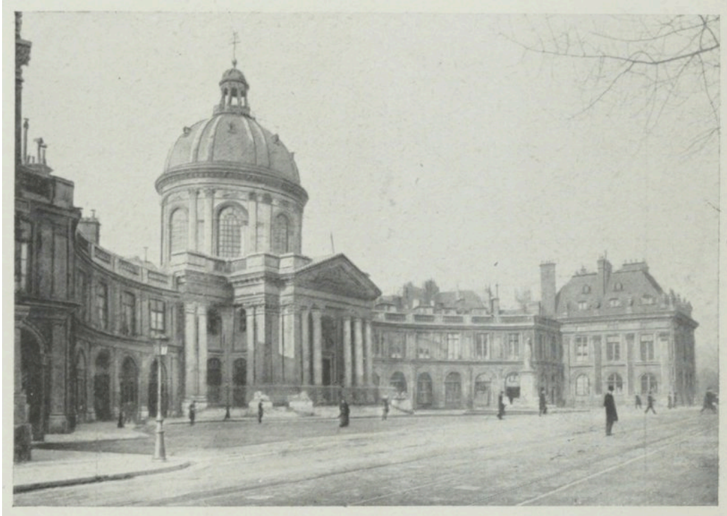
Fig. 51. – PARIS. FAÇADE DU COLLÈGE MAZARIN.
