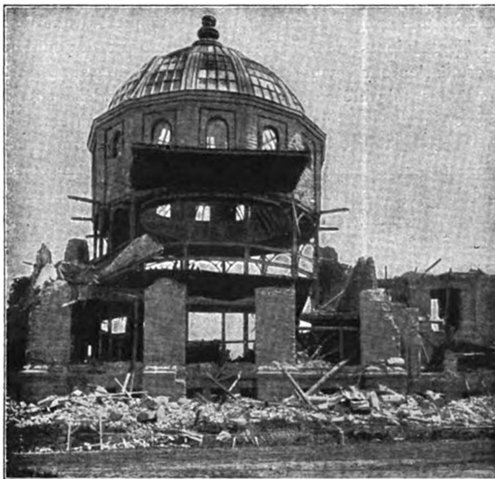
Fig. 14. — Bâtiment (bibliothèque) faisant partie de l'Université Stanford, en Californie, après le tremblement de 1906. On voit la résistance considérable offerte au séisme par la construction métallique, comparée à celle des maçonneries non armées. Pour la résistance des bâtiments en bois, voir la figure 11 .
