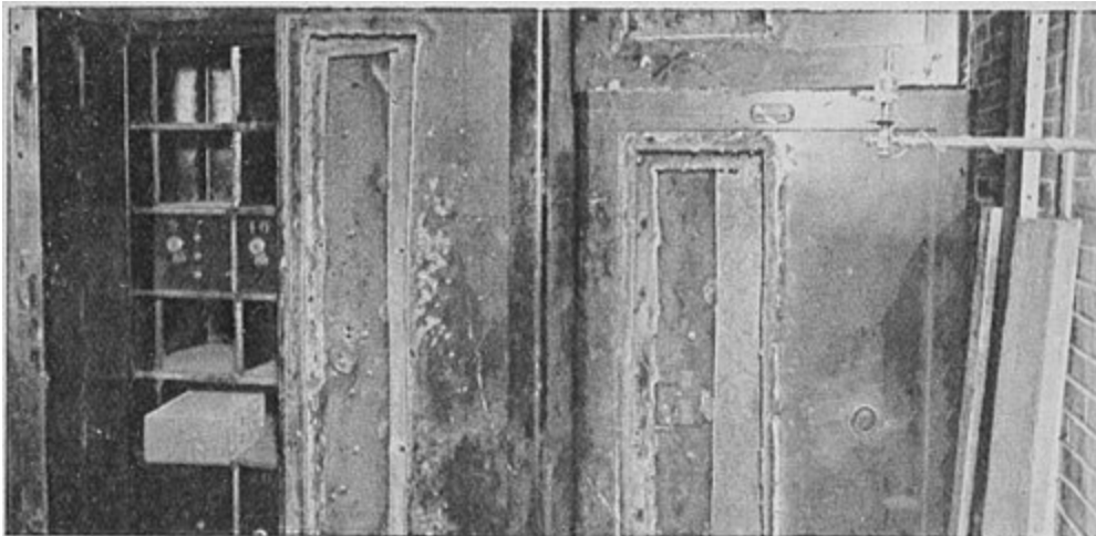
NOYON (Oise). — Les coffres-forts particuliers, à la banque Brière, ouverts à l'aide d'un chalumeau.
