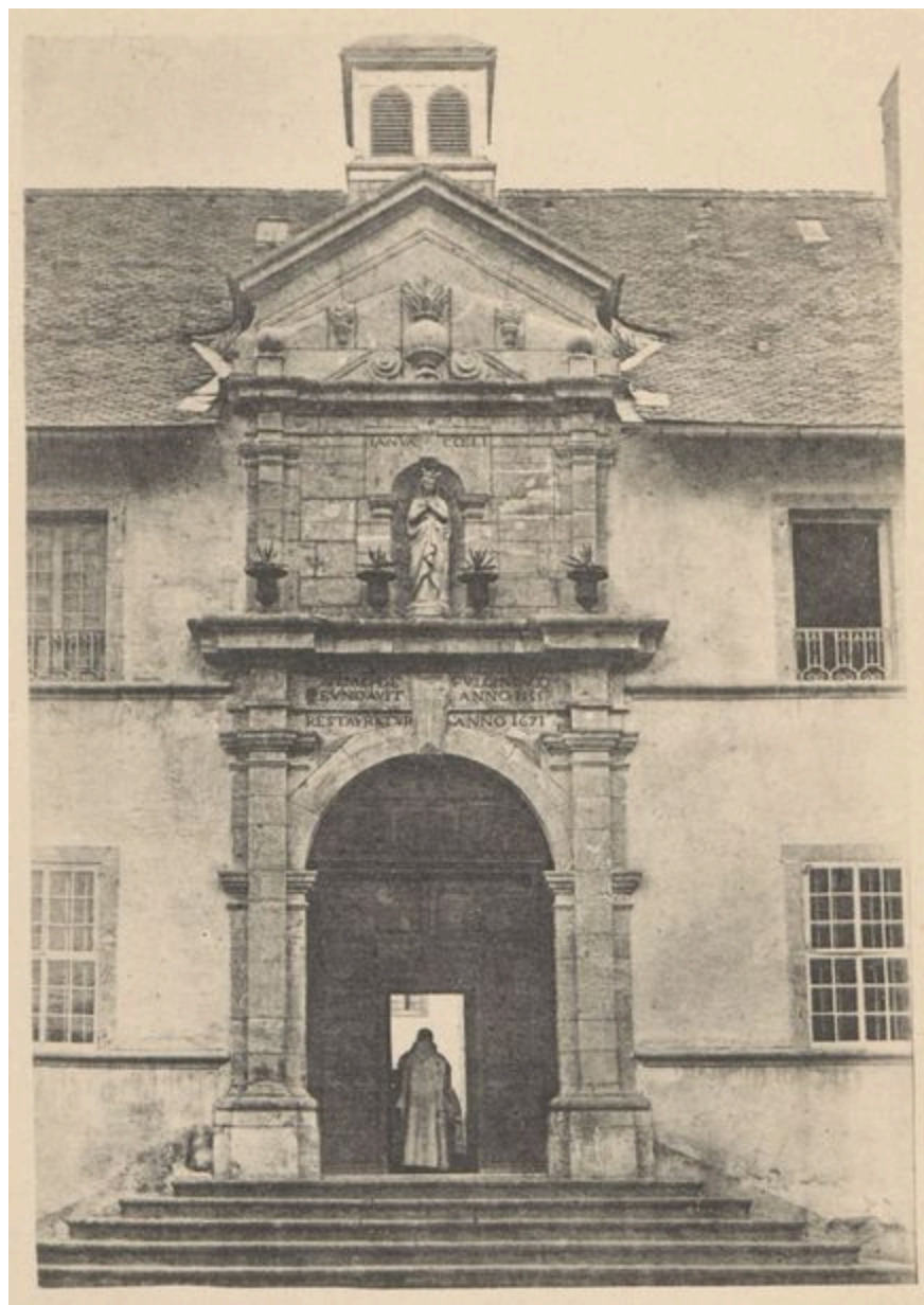
Porte d'entrée du Monastère
