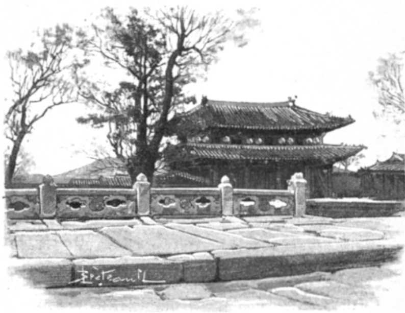
PALAIS VIEUX, COURS D'HONNEUR. PORTIQUE D'ENTRÉE ET PONT SUR LE RUISSEAU.
