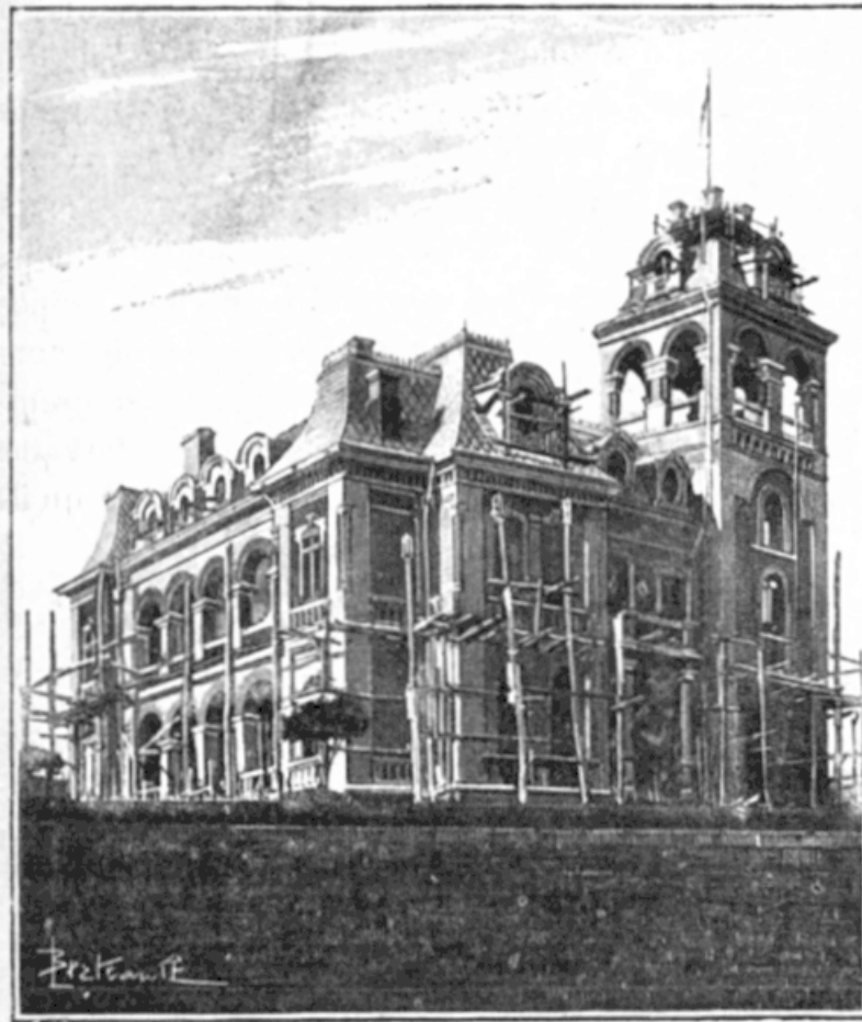
SÉOUL. — NOUVELLE LÉGATION DE FRANCE EN CONSTRUCTION.
