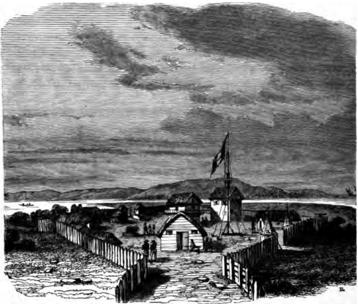
Poste de Grand-Bassam.
