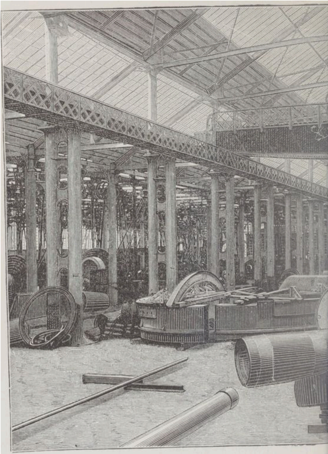
FIG. 34. — Usine de Saint-Chamond de montage avec pont roulant.
