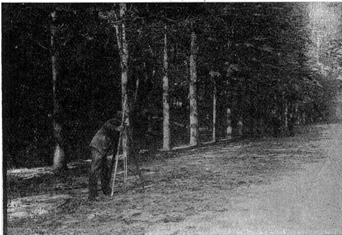
Mesure des bases à l'aide des fils de métal invar. Alignement des repères mobiles.
