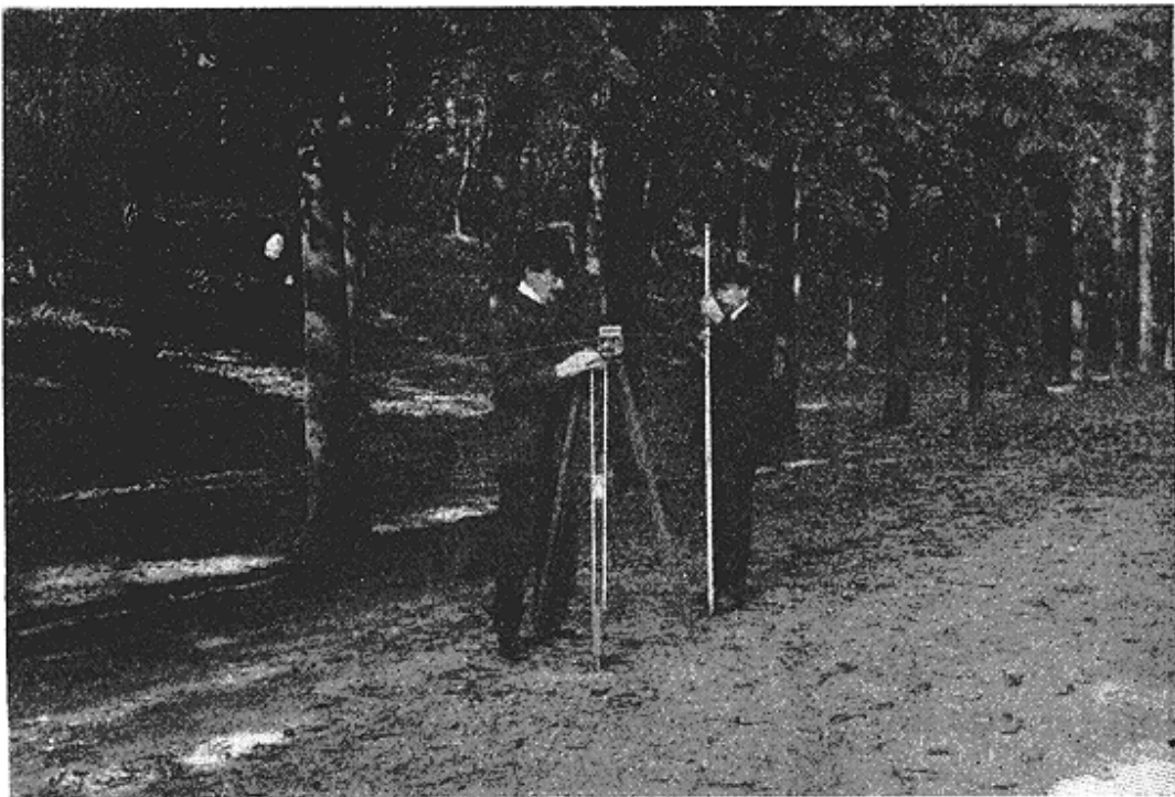
Mesure des bases à l'aide des fils de métal invar de M. C.-E. Guillaume. Mise en place d'un repère mobile.
