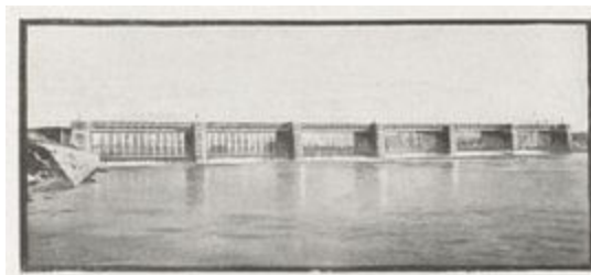
FIG. 98. — BARRAGE DE PORT-MORT.
