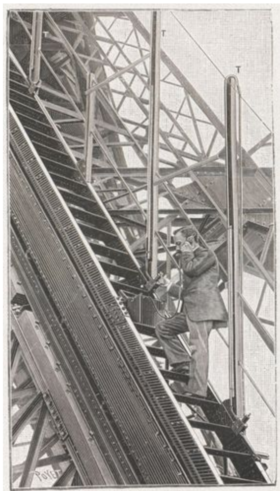
Fig. 49 — Escalier du sol au 1 er étage, le long duquel est établi le manomètre. TTT, tubes de verres verticaux fixés au tube manométrique.
