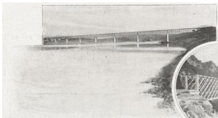
FIG. 73. — PONT DU TAGE.
