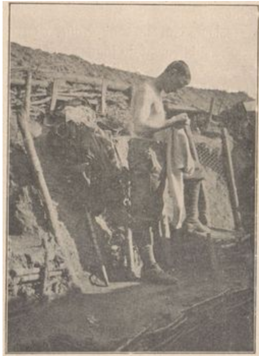
Toilette dans la tranchée.
