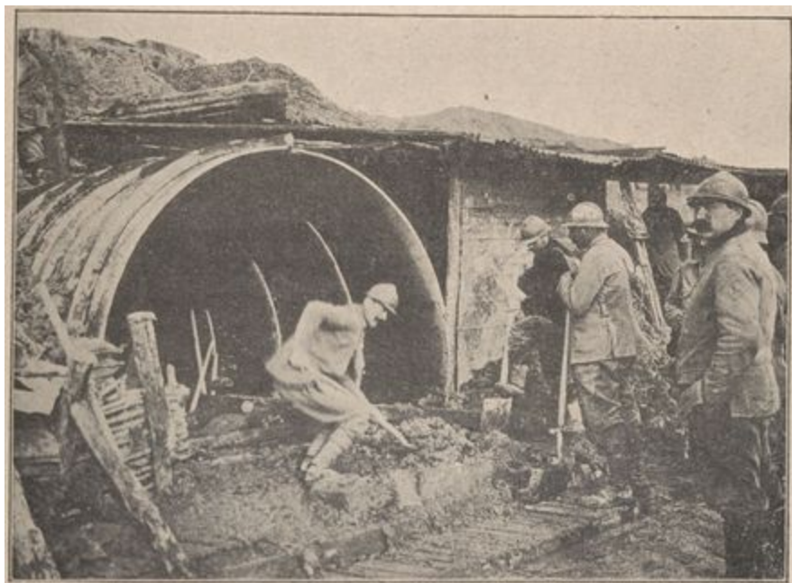
Construction d'un abri blindé.
