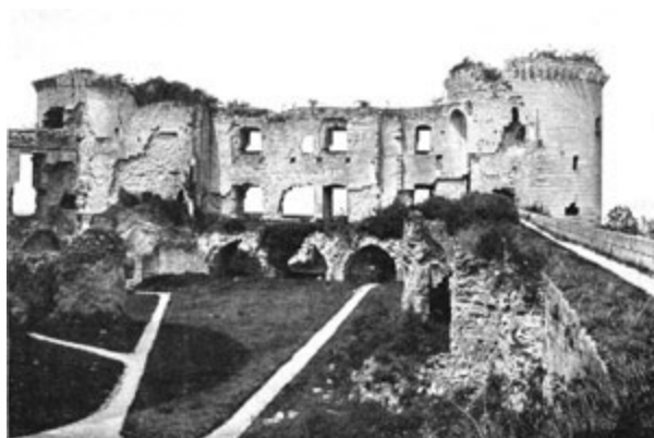
Photo Neurdein. CÔTÉ OUEST DE LA COUR Ruines de la salle des Preuses.
