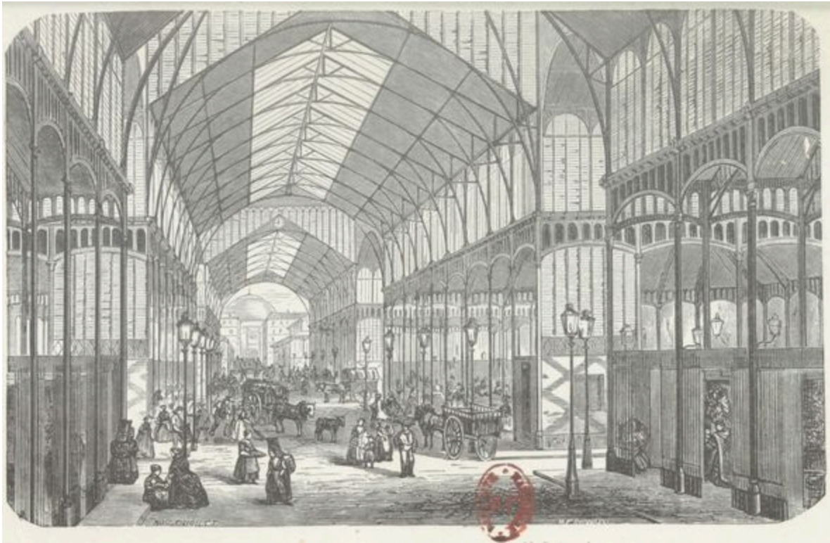
Les halles centrales, construction en fer de M. Baltard.
