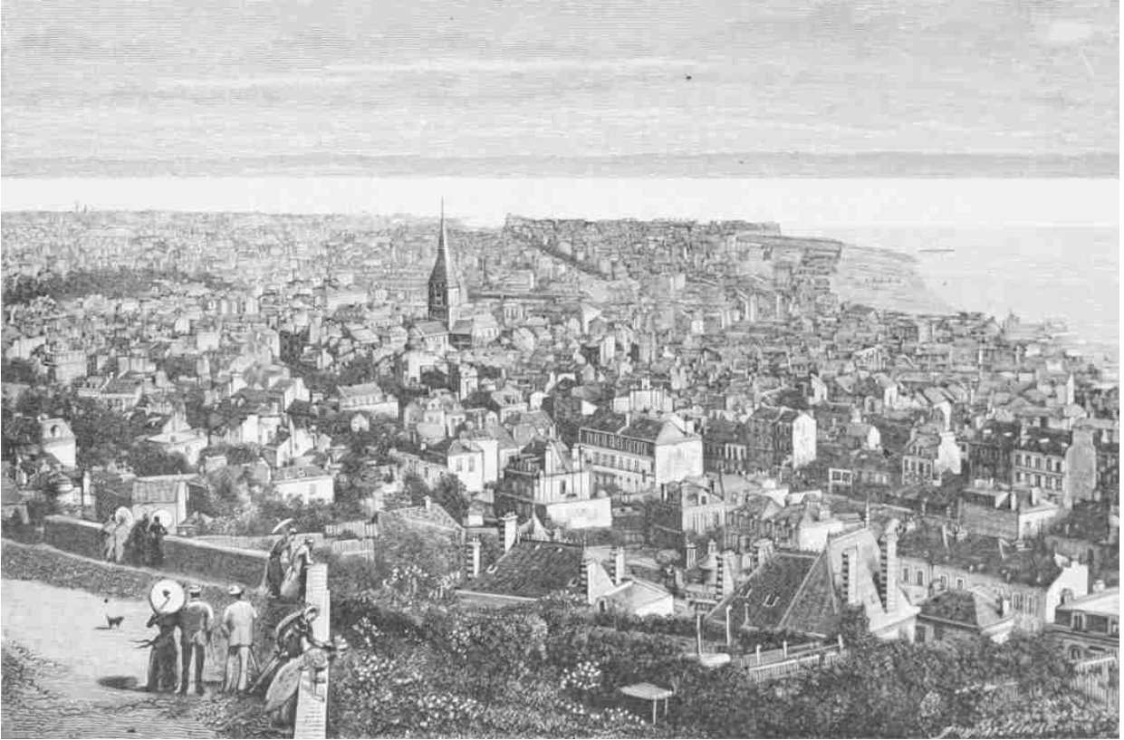
LE HAVRE, VU DE SAINTE-ADRESSE
