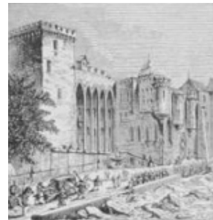
AVIGNON ET LE CHATEAU DES PAPES. —Avignon (40,000 hab.), ancienne capitale du Comtat-Venaissin, sur le Rhône, servit autrefois de résidence aux papes. On y voit encore leur palais, majestueux monument du quatorzième siècle.
