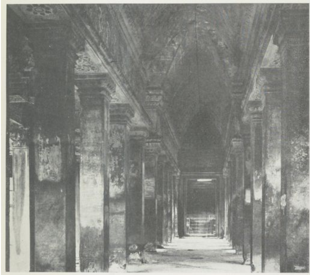
FIG. 87. — Galerie double, voûtée en encorbellement, au temple d'Angkor-Vaht (Siam).
