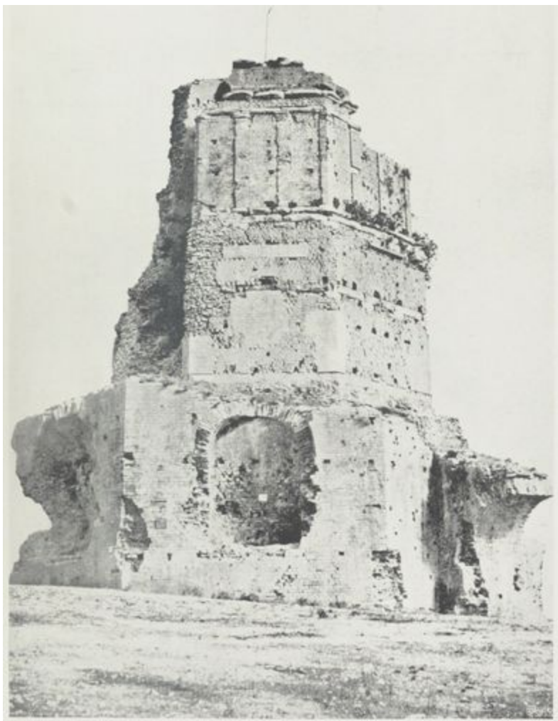
FIG. 152. — Tour « Magne » contiguë à l'ancien réservoir alimentant en eaux potables la ville de Nîmes (France, Gard).
