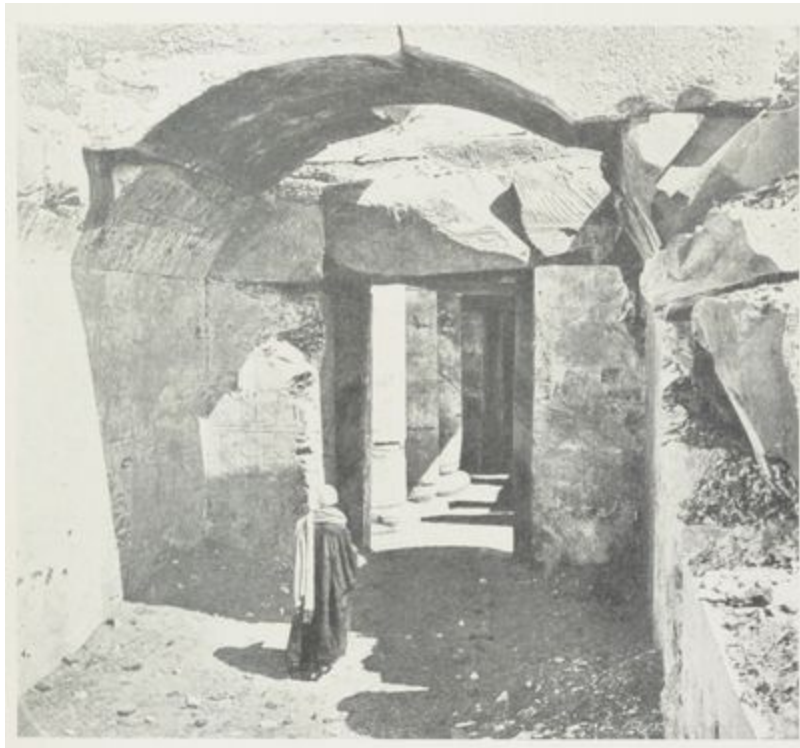
FIG. 16. — Sanctuaire voûté en encorbellement au temple de Seti (Setoui) 1 er à Abydos.
