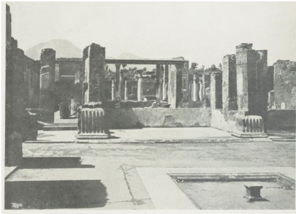
FIG. 160. — Maison du Faune, à Pompeï.
