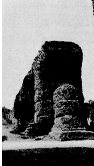
Fig. 47. — Arcades d'amont, au passage de la route.
