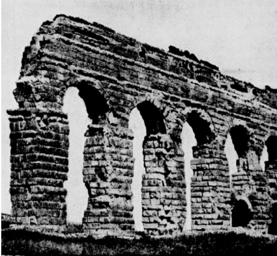
Fig. 81. - Arcades de l'aqueduc Claudia. Structure en grand appareil.
