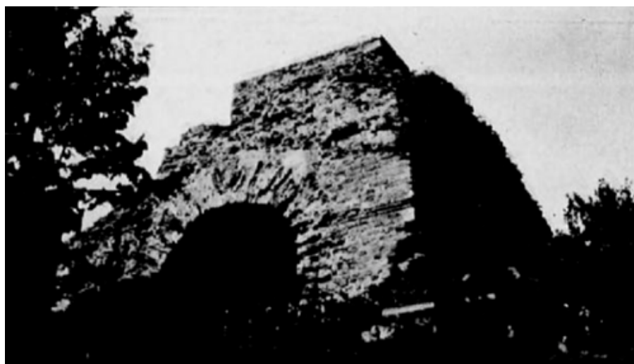
Fig. 16. — Réservoir de fuite du siphon de l'aqueduc de La Brévenne, aux Massues.
