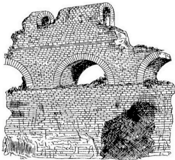
Fig. 104. — Aqueduc de Fréjus. Substructions à jours.
