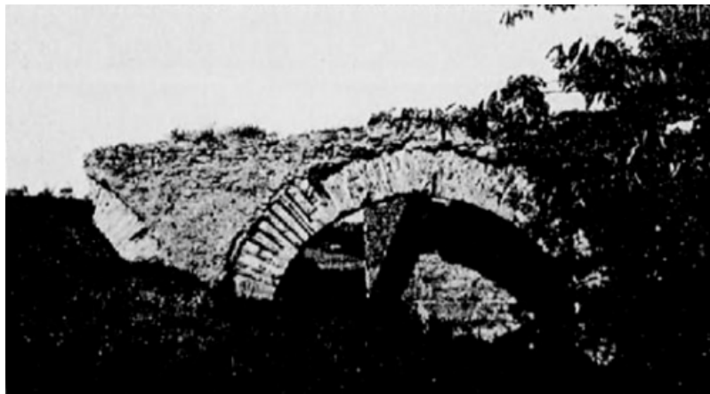
Fig. 27. — Pont de la Condamine, vue des arcs d'aval.
