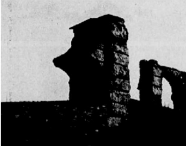
Fig. 53. — Siphon de Saint-Irénée. Réservoir de chasse.
