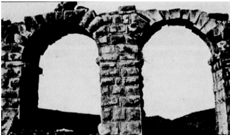
Fig. 89. — Pont de l'oued Gatoussi (V. fig. 87). Aspect des bossages.
