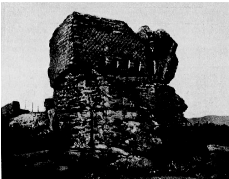
Réservoir de Soucieu. État actuel du monument.
