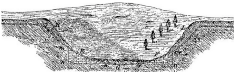
Fig. 71. — Profil d'un siphon d'aqueduc romain suivant Belgrand.
