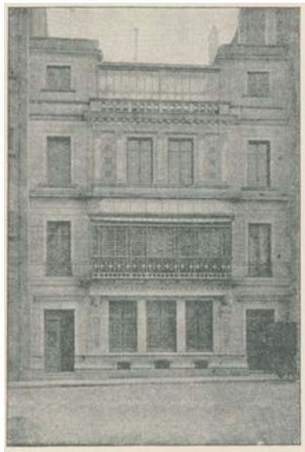
Vue extérieure des ateliers Gillot
