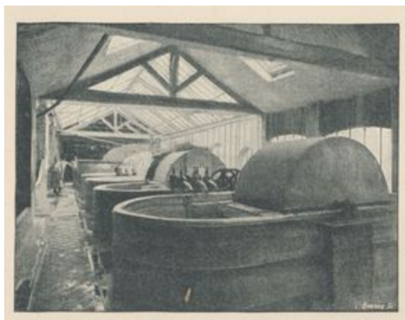
Batterie des piles Blanchisseuses Usine Firmin-Didot
