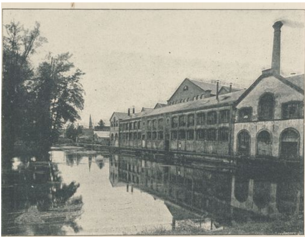
Usine Firmin-Didot, à Sorel-Moufssel (Côté sud)
