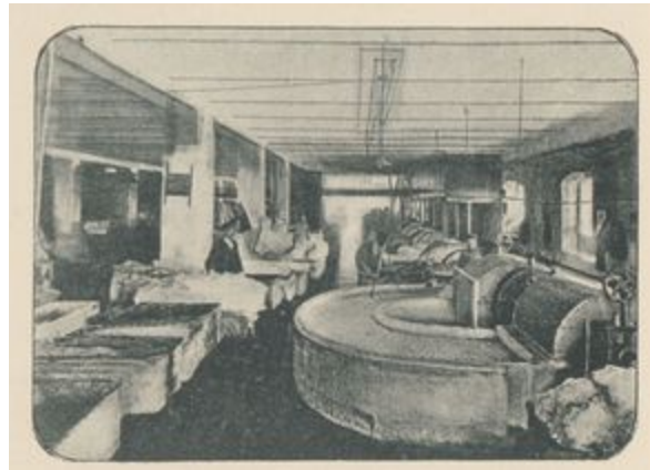
Raffineuses & Défileurs de chiffons & pâtes de bois Papeterie de la Haye-Descartes
