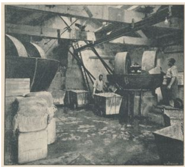
Moulins à broyer la pâte de bois Usine Firmin-Didot
