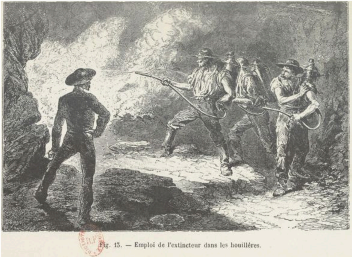
Fig. 13. — Emploi de l'extincteur dans les houillères.
