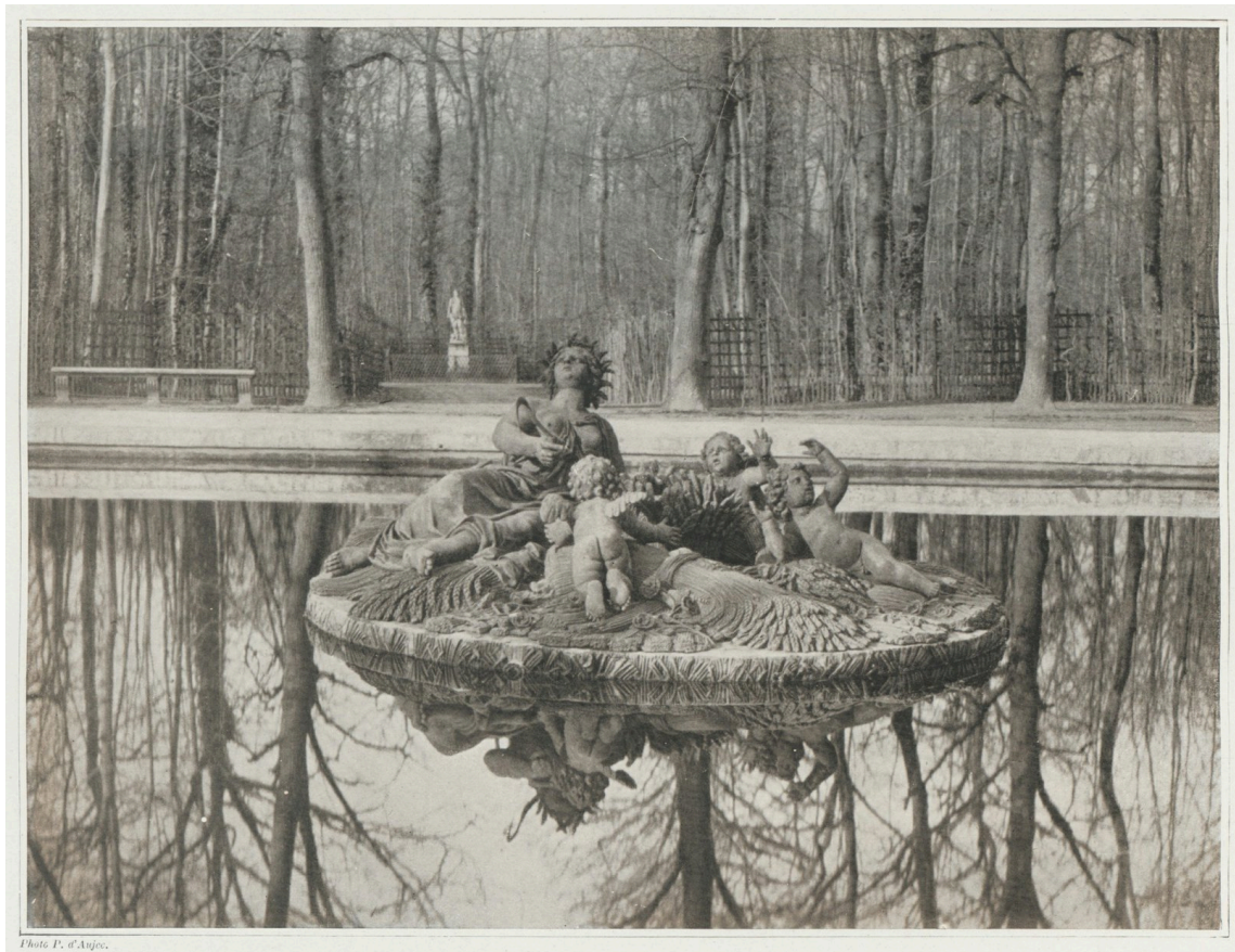
LA FONTAINE DE CÉRÈS OU DE L'ÉTÉ Sculpture de plomb par Thomas Regnaudin, mise en place en 1674
