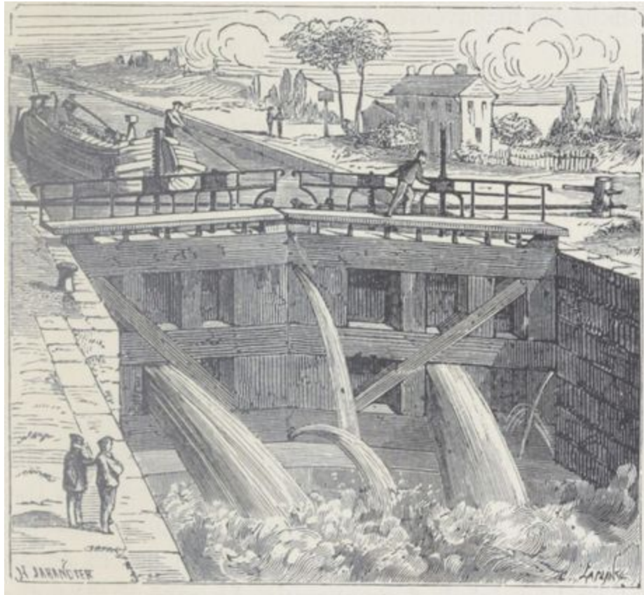
Digue pour la navigation, écluse.
