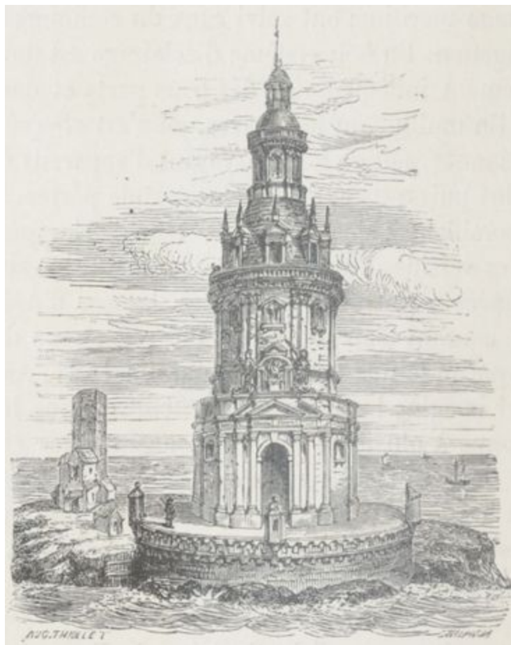
Ancienne tour de Cordouan.
