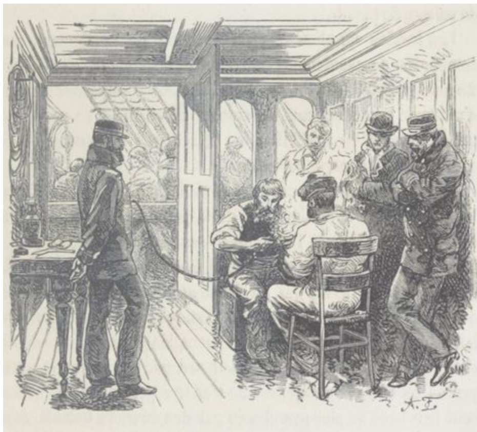
Fig. 93. — Opération de la soudure du câble.
