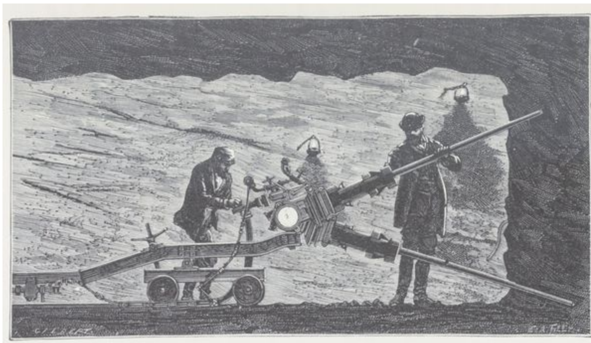
Fig. 54. — Exécution du grand tunnel de l'Arlberg. — La machine à eau comprimée Brandt dans la galerie Ouest.
