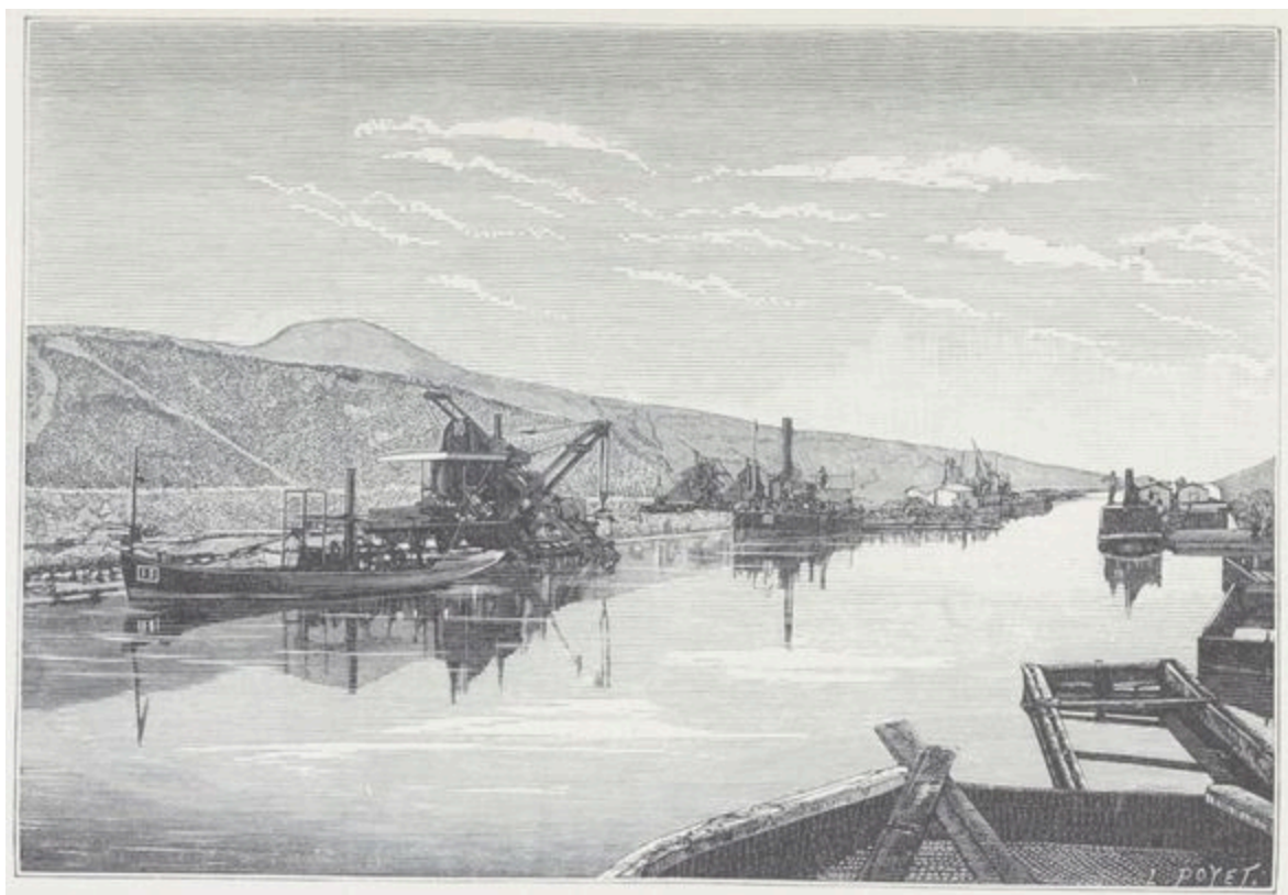
Fig. 6. — Exécution du canal maritime de Suez. — Les excavateurs dans la grande tranchée d'El-Guisr.
