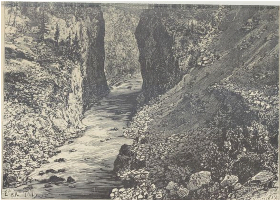
La ligne internationale du S t -Gothard pendant sa construction. - Le passage de la Reuss sur le versant nord des Alpes Helvétiques.
