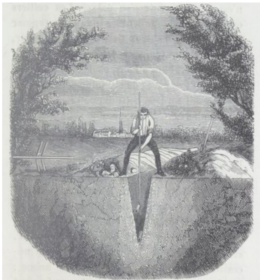
Fig. 182. — Ouvrier posant les tuyaux.
