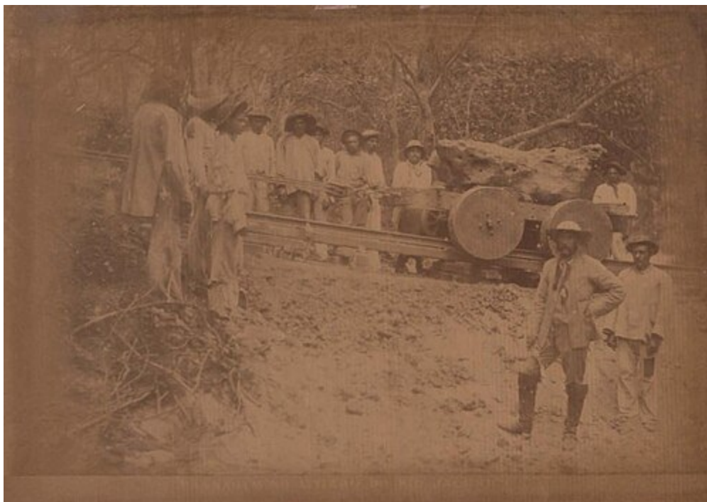
PASSAGEM NO ATTERRO DO RIO JACURICY. (PASSAGE SUR LE REMBLAI DE LA RIVIÈRE JACURICY.)
