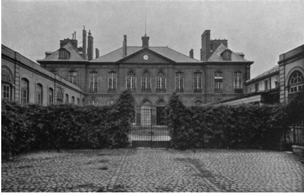
HOTEL BIRON.—COUR D'HONNEUR. (Avant la démolition des Annexes.) Cl. Lémery
