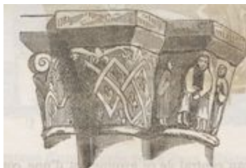
N° 4. — Pile du sud-ouest.
