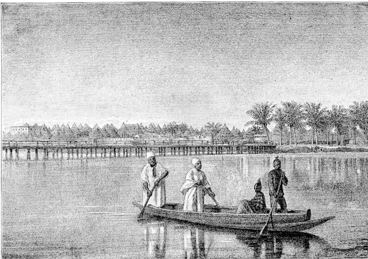
Pont sur le Sénégal à Saint-Louis.
