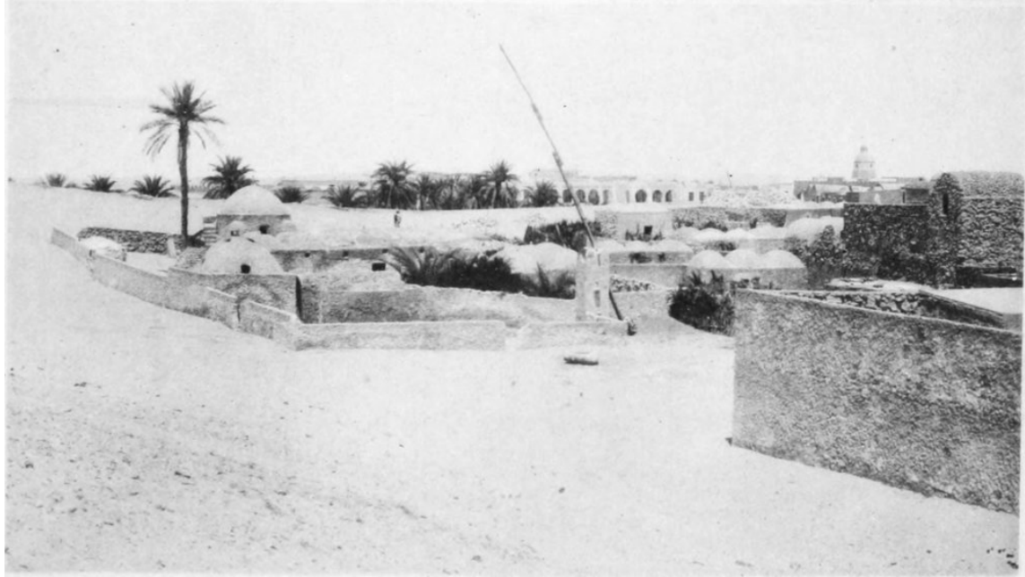
10. Maisons d'El Oued. Au milieu, un puits à balancier. (Voir p. 246 et 247.)
